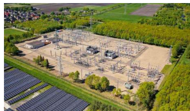
Zonnevelden in de buurt van een transformatorstation (Transformatorstation Zeljerveen Assen TenneT Holding B.V. 2020)
