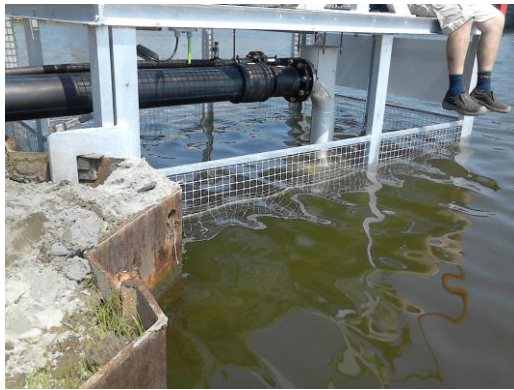
Figuur 3.3 | Inlaat van een TEO systeem. De inlaat kan boven water geplaatst worden onder een steiger (links). De inlaat kan ook onder water geplaatst onder een steiger.
